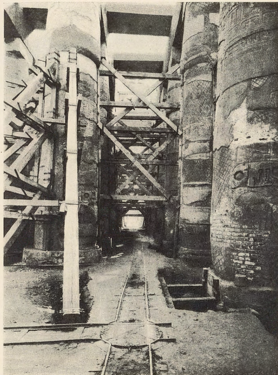
Vue générale des étais dans l'allée transversale.
